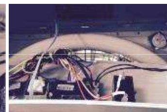
Conectar o cabo de comunicação do controle e o cabo do motor do swing
