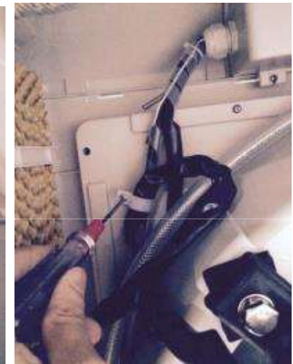
Fixar os cabos e a mangueira
