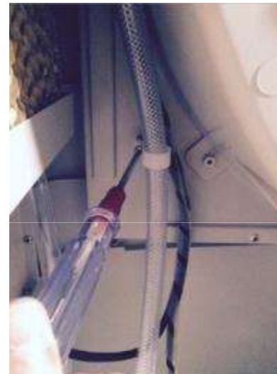
Fixar os cabos e a mangueira
